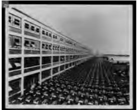
フォード社のハイランドパーク工場で大衆生産されたT型車の車台(1913年) From the Collections of The Henry Ford.
