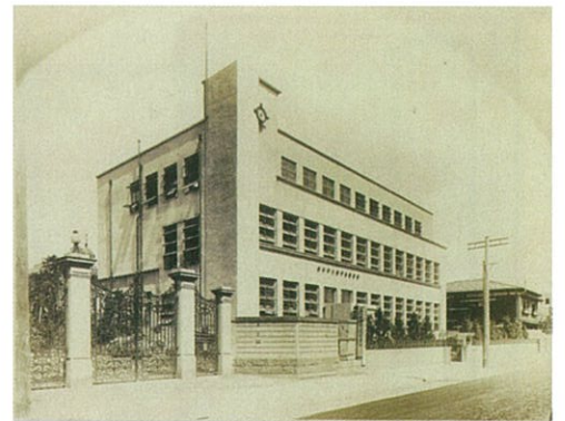
駿河台図書館全景 (130-001) 千代田図書館所蔵「一橋・駿河台図書館業務資料」
