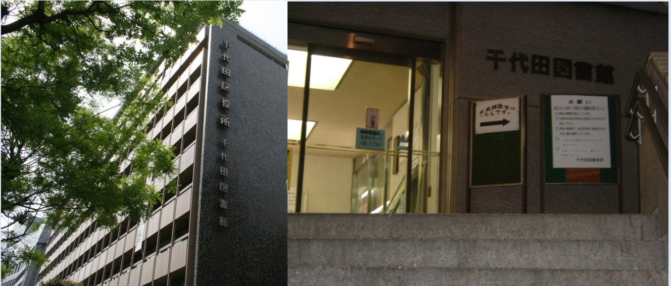
浅岡氏が閲覧に赴いた当時の面影が残る、千代田区役所本庁舎とその隣にあった千代田図書館(2005年5月撮影)。2007年5月、千代田区役所本庁舎と千代田図書館は、現在の九段第三合同庁舎内に移転した。
